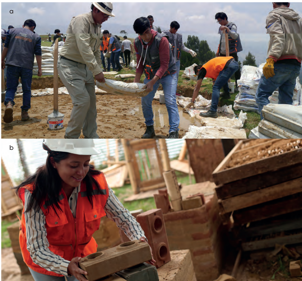
Figura 11. Trabajos conducidos por el Laboratorio en tierra
